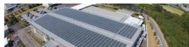
▲ ソディック エフ・ティ宮崎事業所 社屋上の太陽光発電システム
